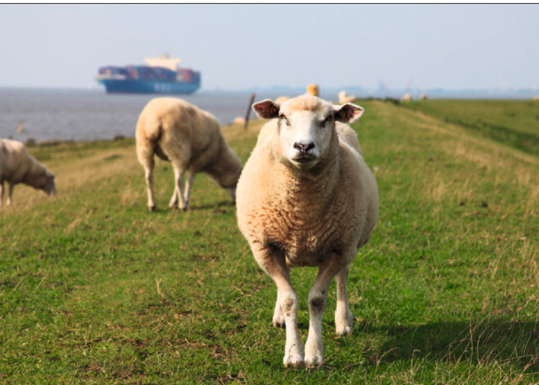
Hauptdeiche an der Flussmündung dienen dem Schutz vor Sturmfluten
