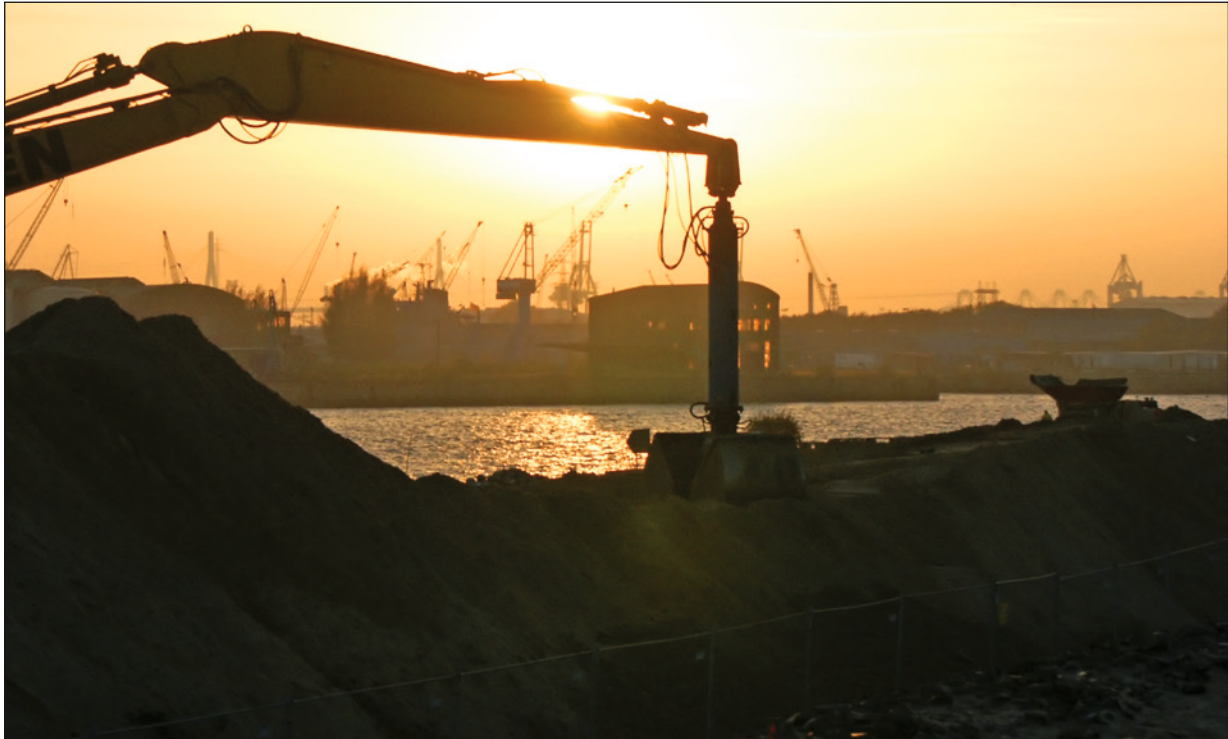
Folgekosten der Vertiefungen durch zunehmende Baggermengen in den Häfen.
