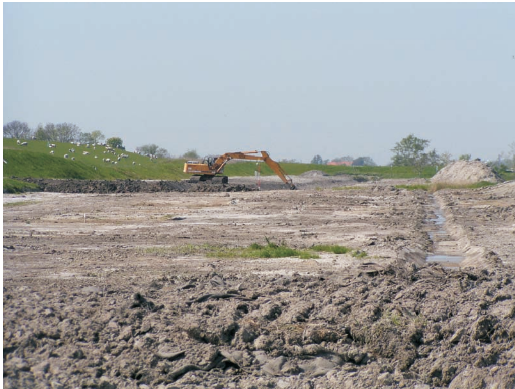
Abb. 11: Deichbauarbeiten © WWF / B. Claus
