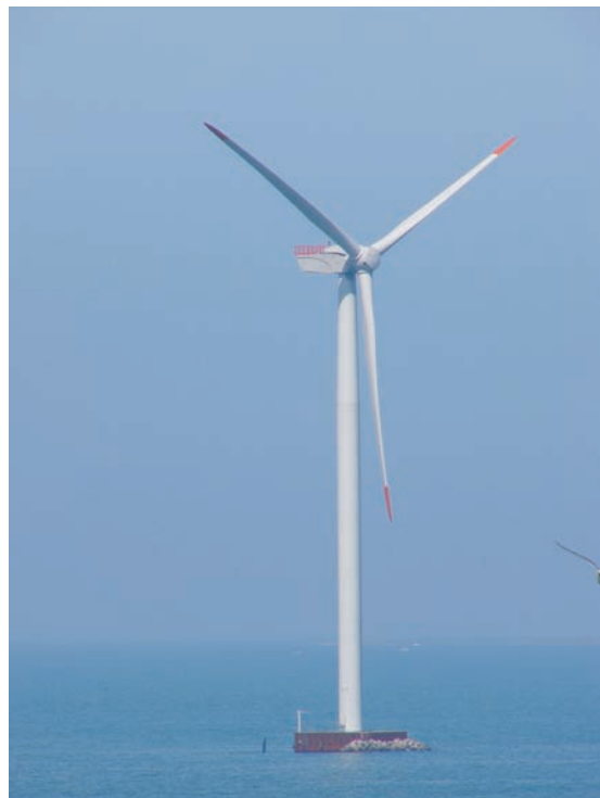
Abb. 10: Windpark-Anlage bei Frederikshavn © WWF / H.-U. Rösner
