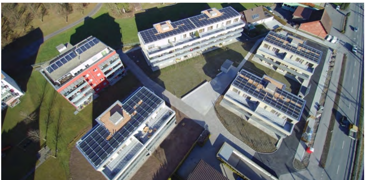
Abbildung 8: Das Quartier Schwemmiweg in Walenstadt
