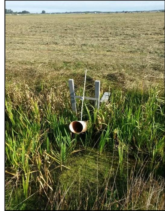
Regelbare Stauanlage in einem Graben
