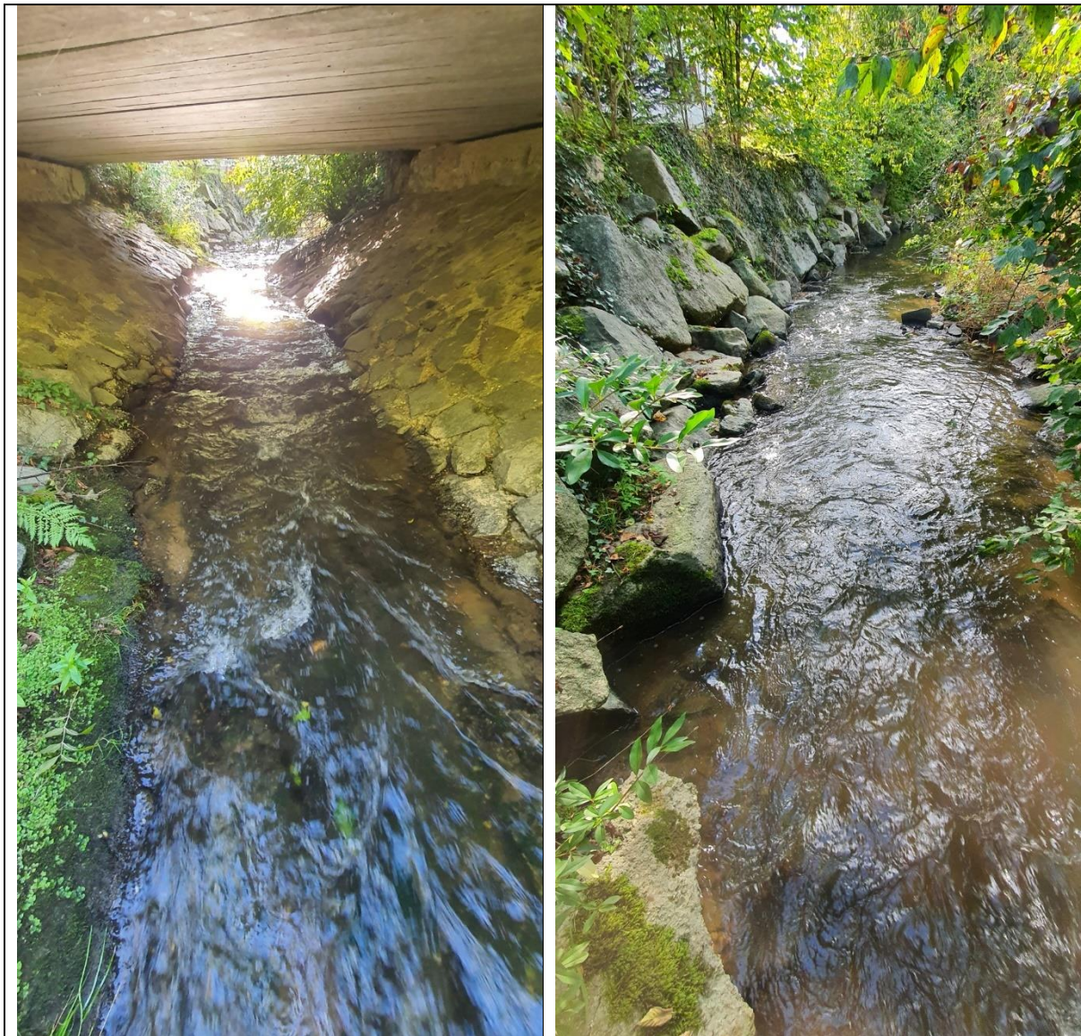
Querbauwerk 10: Durchlass. Links: Durchlass mit steilem Brückenbankett. Blickrichtung nach Westen. An den Oberkanten Losung vom Fischotter. Rechts: Ende des Durchlasses mit Flussbausteinen zur Ufersicherung. Blickrichtung nach Westen.
