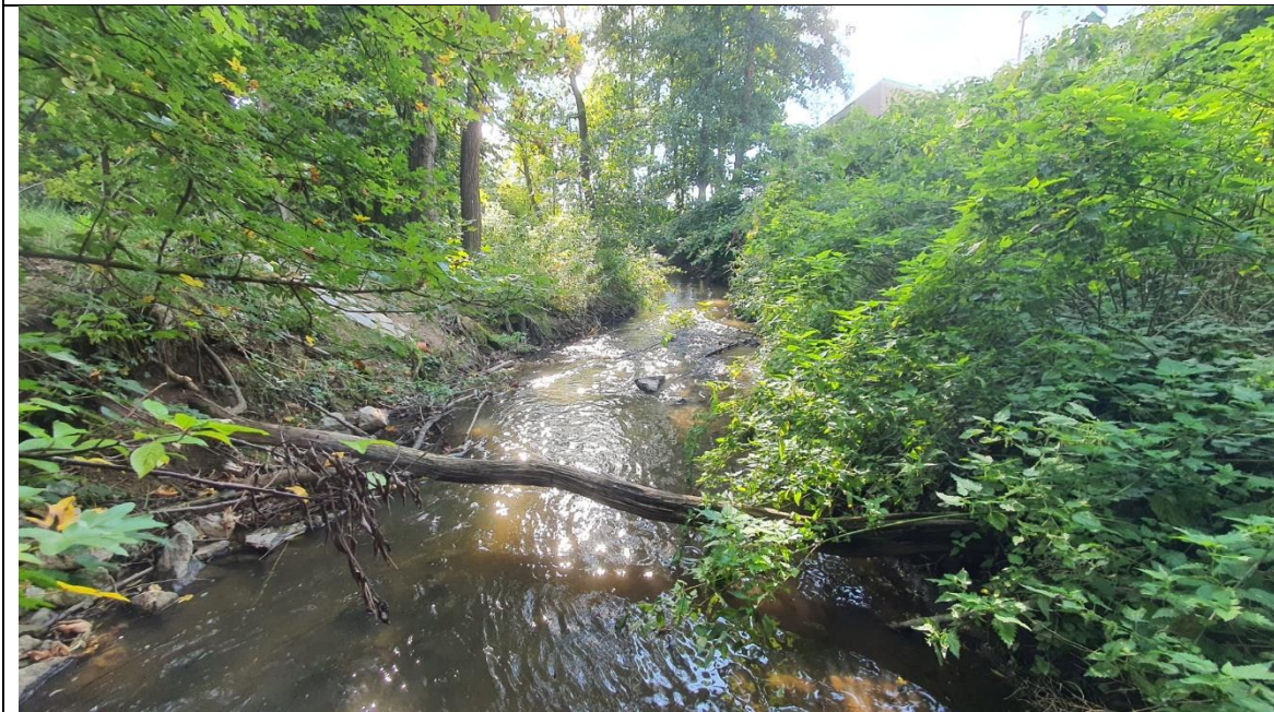
Querbauwerk 8: Reste eines Absturzes. Oben: Absturz nicht mehr sichtbar. Blickrichtung nach Norden. Unten: Blickrichtung nach Süden.
