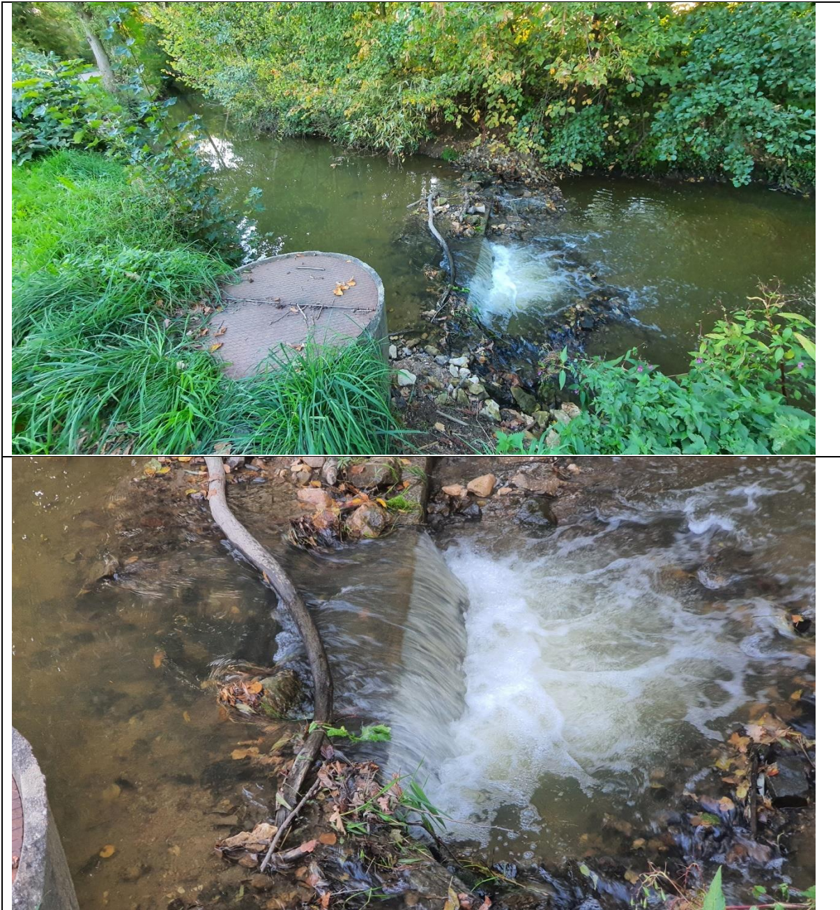
Wenzenbach: Querbauwerk 2 : Absturz (0,4 Meter) mit abgelöstem Wasserstrahl, Hölzlhof 1, 93173 Wenzenbach. Oben und unten : Blickrichtung nach Westen.
