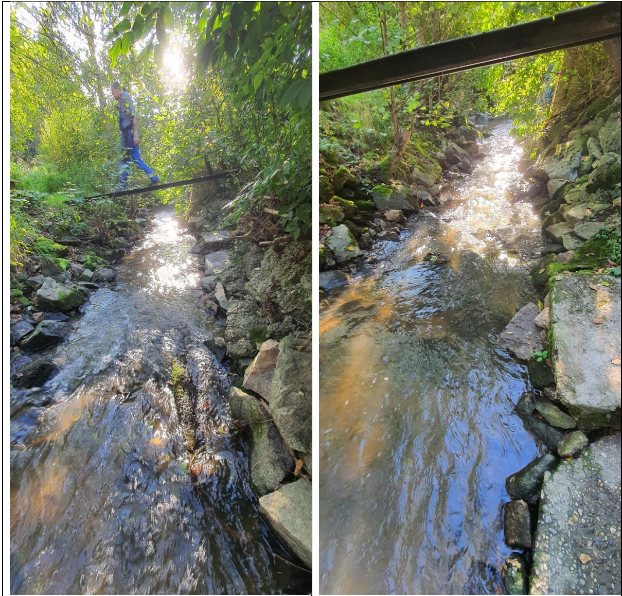
Querbauwerk 12: Sohlengleite. Links und rechts: Sohlengleite mit Blickrichtung nach Westen.
