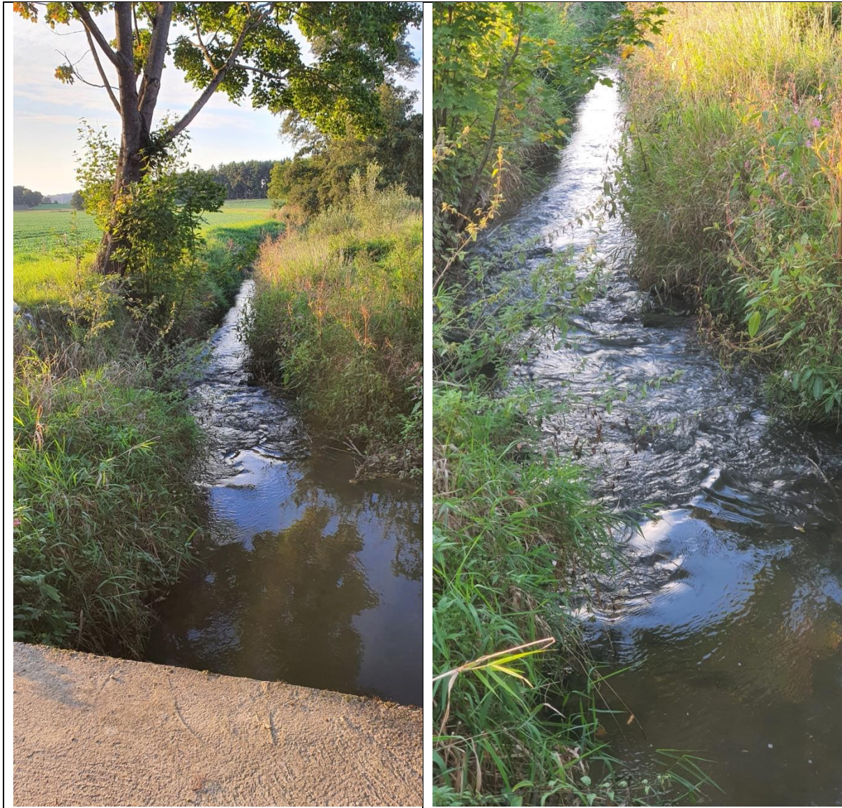
Wenzenbach: Querbauwerk 1 , Sohlgleite Hölzlhof 1, 93173 Wenzenbach. Aufnahme links mit Betonbrücke im Vordergrund. Blickrichtung beider Aufnahmen Richtung Nordwesten.
