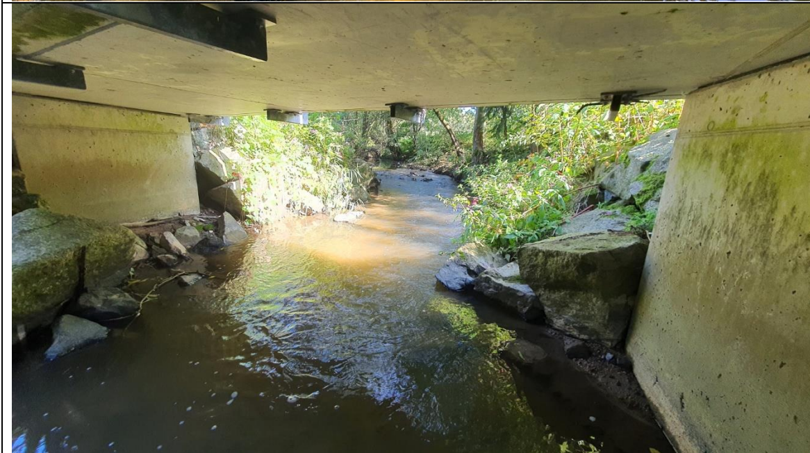
Wenzenbach Querbauwerk 5 , Fussgängerbrücke mit Bankett aus Flussbausteinen bei Grafenhofen. Brückenpfeiler bilden einen Durchlass, der frei durchgängig für Fische ist. Oben: Blickrichtung flussabwärts nach Südwesten. Unten: Blick flussabwärts Richtung Westen.
