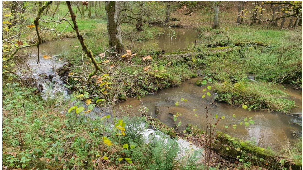
Querbauwerk 13: Wasser stürzt über Wehrabsturz/Totholz. Im Hintergrund ist der Aufstau des Wenzelbachs zu erkennen. Leicht erhöhter Wasserstand am 28.10.2025. Blick vom Radweg nach Osten.
