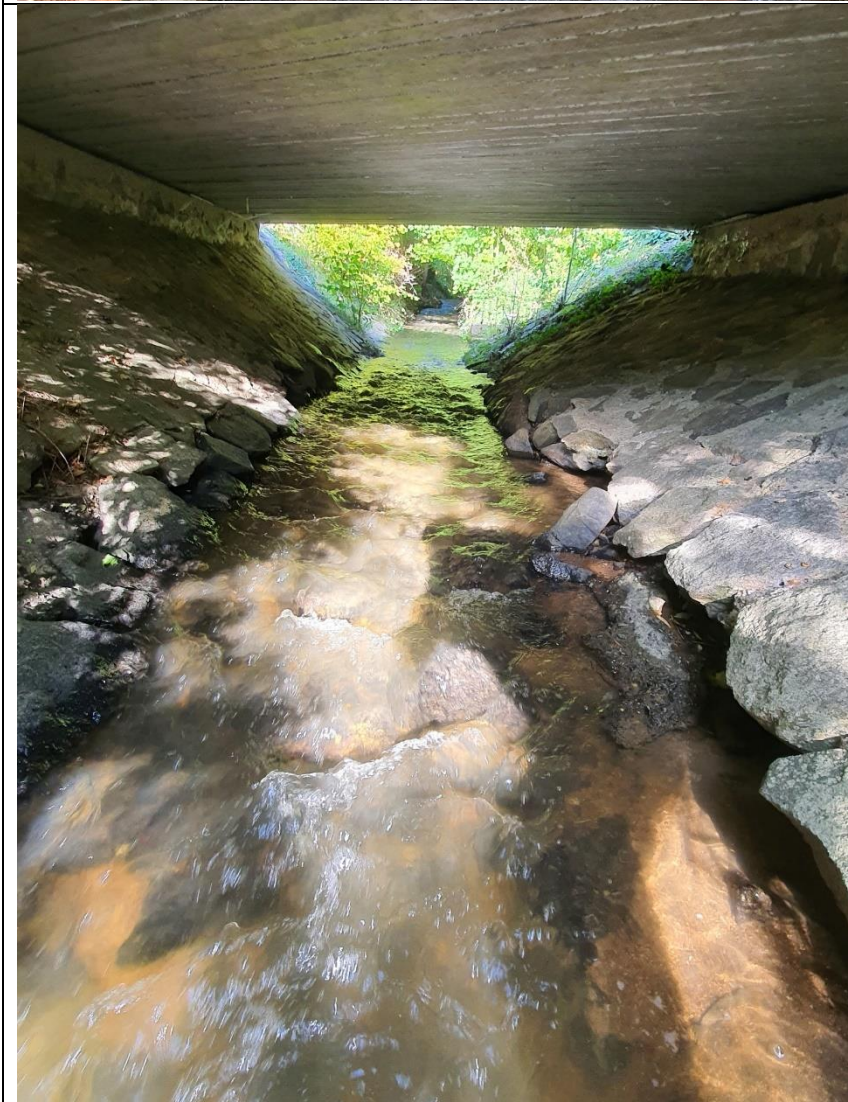
Querbauwerk 11: Sohlenrampe. Oben Sohlenrampe mit gemauertem Ufer. Blickrichtung flussaufwärts nach Osten. Unten: nahtloser Übergang der Sohlenrampe (Querbauwerk 11) in den Durchlass unter der Brücke (Querbauwerk 10) Blickrichtung nach Osten.
