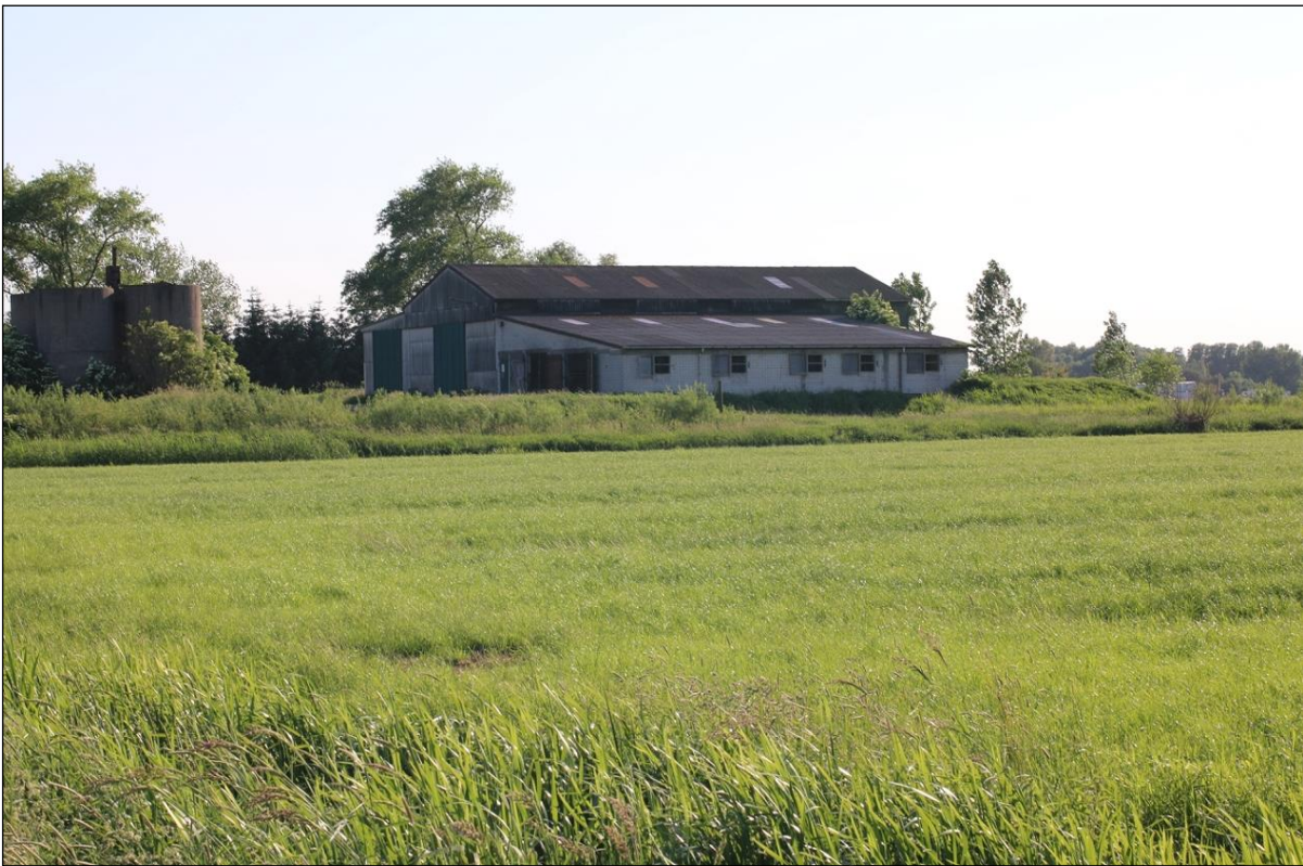
Abb. 49: Nicht mehr benötigte landwirtschaftliche Produktionsanlagen im Bereich Krautsand, die rückgebaut werden können.
